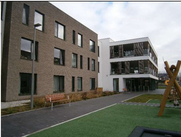
Fotografía 3. El acceso principal a WZC De Zon cuenta con varios aparcabicis para fomentar la movilidad activa de los trabajadores y visitantes. Fuente: autora, 2020.
