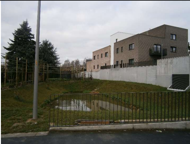
Fotografía 2. Aljibe en superficie para la captación y gestión de aguas pluviales. Fuente: autora, 2020.
