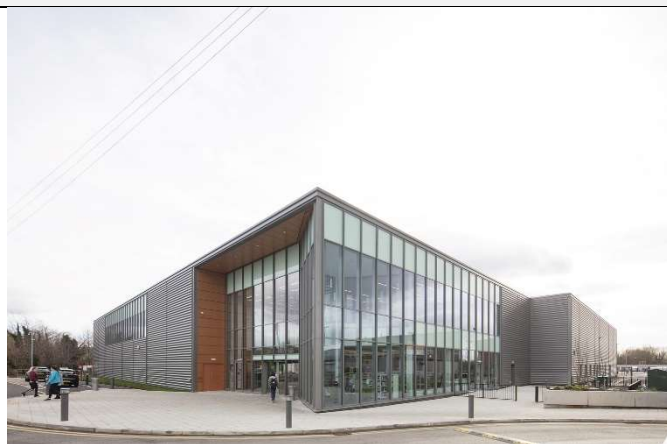
Fotografía 1. El centro Great Sankey Community Hub es un equipamiento multifuncional para la promoción de la salud y del bienestar. Se trata de un proyecto de regeneración urbana, en sustitución de un antiguo equipamiento de ocio obsoleto.
