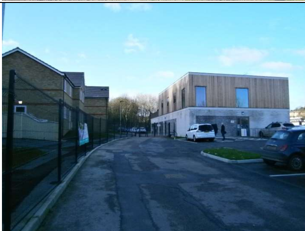
Fotografía 3. El acceso principal es una calle tranquila en fondo de saco, con un aparcamiento al lado de la entrada principal. Varias de las viviendas avanzan antes de la puerta de entrada, separadas por una verja metálica. No hay aceras como tal, el espacio inmediato permite la circulación de vehículos. La escala de las viviendas y el nuevo edificio está integrada con el entorno, manteniendo la estética en la rehabilitación de las viviendas.
