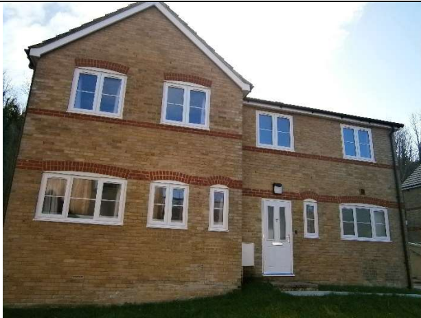
Fotografía 7. La rehabilitación de las viviendas ha mantenido la estética original, integrada en el entorno. Fuente: autora, 2020.
