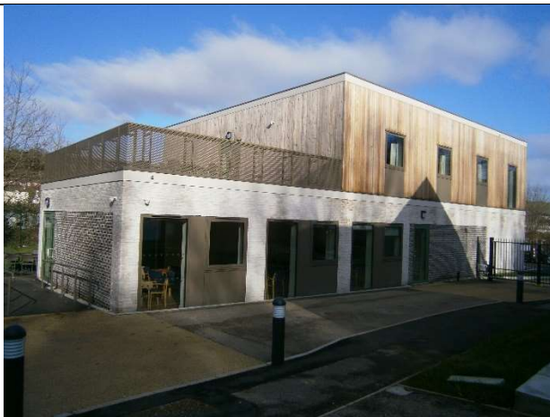
Fotografía 8. Enfrente de las 6 viviendas se ha construido un nuevo centro comunitario para la centralización de algunos servicios, como la cocina, despachos, salas comunes para visitantes y residentes y cafetería. Fuente: autora, 2020.
