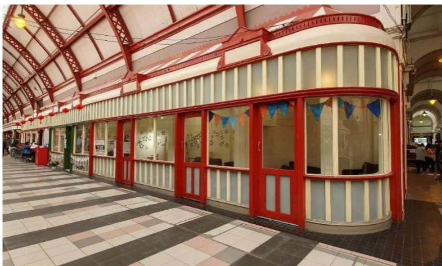
Figura 26. Puesto reformado y habilitado para desarrollar actividades Dementia-Friendly en el interior del Grainger Market. Fuente: Newcastle City Council.
